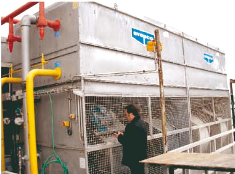
*Figura 78. Detalle de planta frigorífica, zona de condensadores, de la industria tratada.
