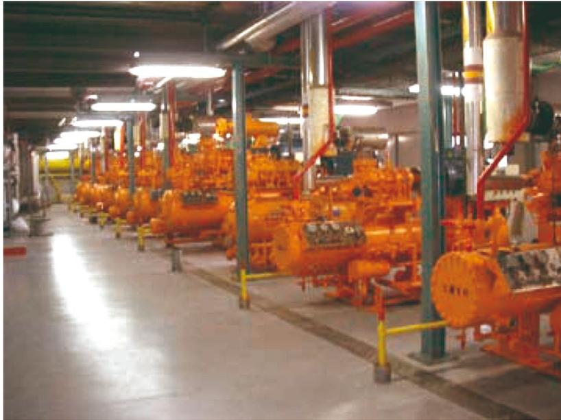
*Figura 77. Detalle de planta frigorífica, zona de compresores, de la industria tratada.
