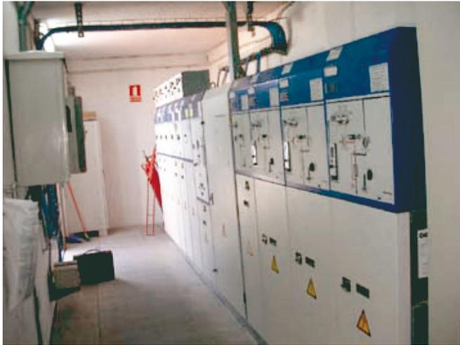
Figura 61. Zona de actuación de maniobras interruptores de alta tensión. Fuente: elaboración propia
